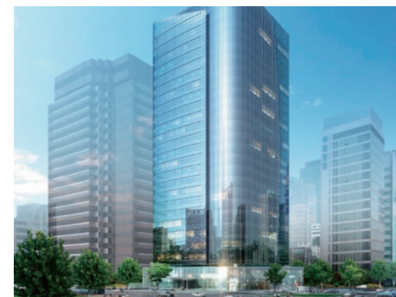
韓銀本店 (54038㎡-ダクト25000㎡)
