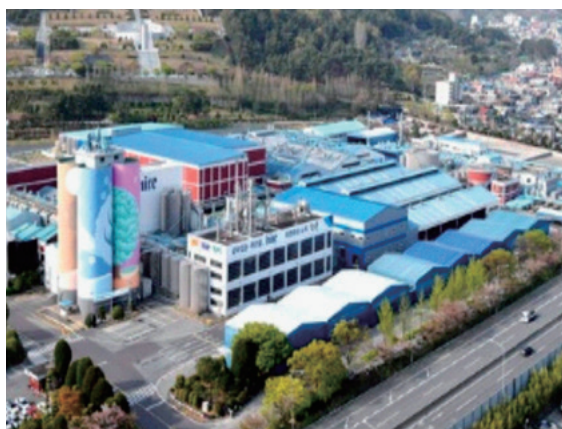
ビール工場 (ダクト8800㎡)
