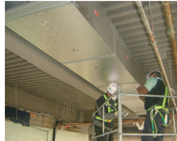
直管ダクト設置
