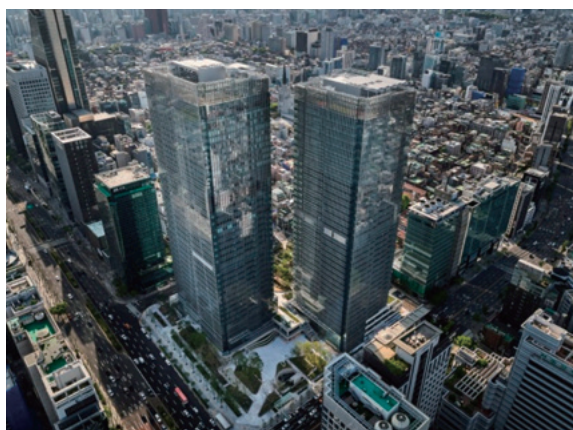
江南ルネッサンスセンター (239180㎡-ダクト35000㎡)
