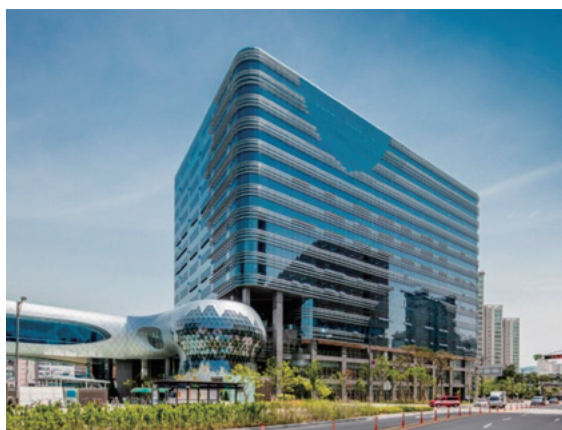
板橋αドーム (87816㎡-ダクト15900㎡)
