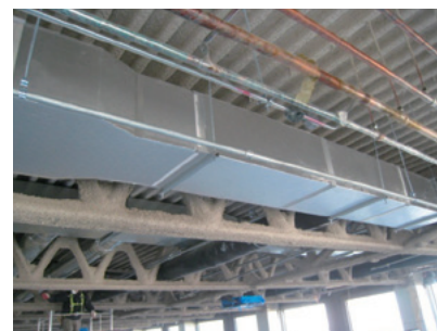
直管ダクト接続
